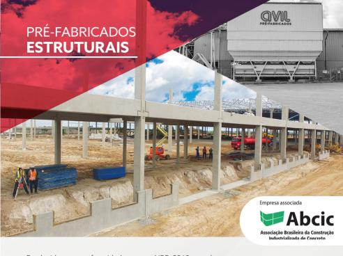
Produzido em conformidade com a NBR 9062, os elementos estrurais (vigas, pilares, lajes, sapatas, aduelas, bocas de lobo) possuem maior qualidade e alto controle tecnológico na fabricação. Através da sua elevada durabilidade reduzem os custos de manutenção. Além disso os Pré - moldados estruturais geram a diminuição do tempo de execução da obra e da produção resíduos.
